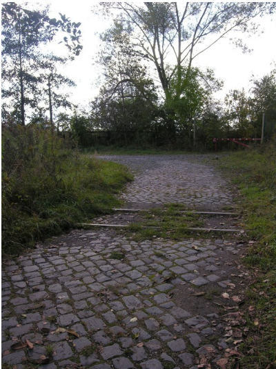
Kohlebahn zur Fabrik Zipsen - Bahnübergang des Weges Wuitz-Oberhaide, Reste des Gleises; Blick S Fotograf/Urheber: NAME FEHLT
