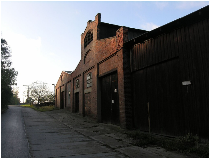
Mineral-Oel-und-Paraffin-Fabrik Rehmsdorf - Gebäudebestand; Blick S Fotograf/Urheber: NAME FEHLT
