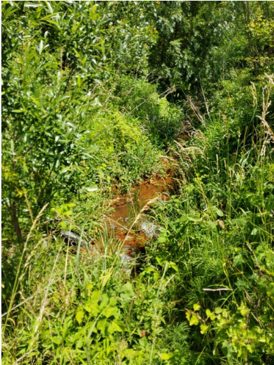
Umverlegung Floßgraben - Stelle, an der der Floßgrabenableiter wieder aus dem Tagebau austritt Fotograf/Urheber: NAME FEHLT
