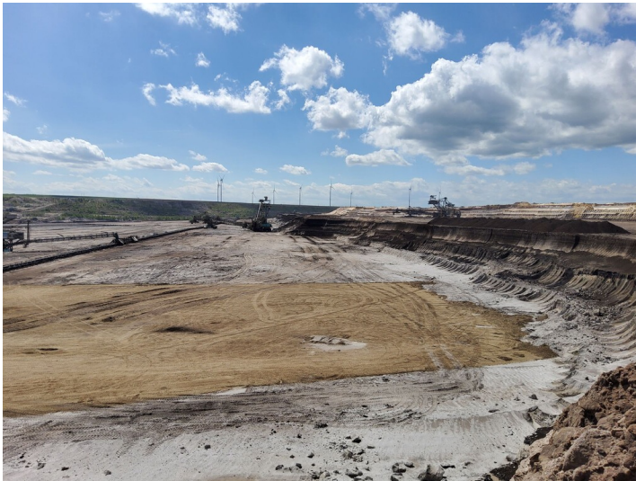
Abbaufeld Profen-Nord - Blick in den Tagebau Fotograf/Urheber: NAME FEHLT
