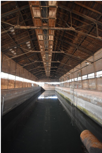
Ziegelei Reuden - ehemaliges Sumpfhaus zum Einsumpfen des Tones vor der Verarbeitung Fotograf/Urheber: NAME FEHLT
