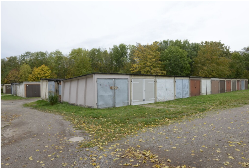
Standort Beton- und Kieswerk Merseburg Süd - Beton-Fertigteilgarage, sog. "Leuna-Glocke" Fotograf/Urheber: NAME FEHLT
