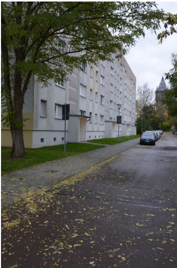
Wohngebiet „Leunaer Straße“ und Sixtviertel Fotograf/Urheber: NAME FEHLT
