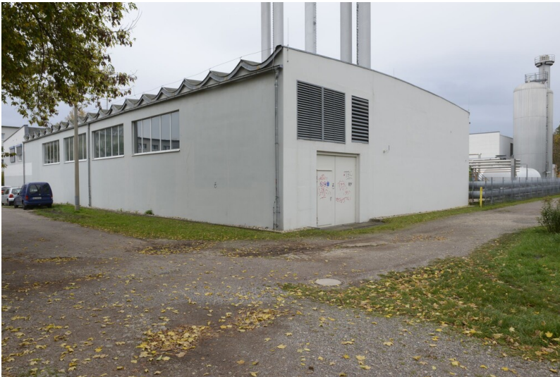
Kraftwerk Merseburg-West Fotograf/Urheber: NAME FEHLT
