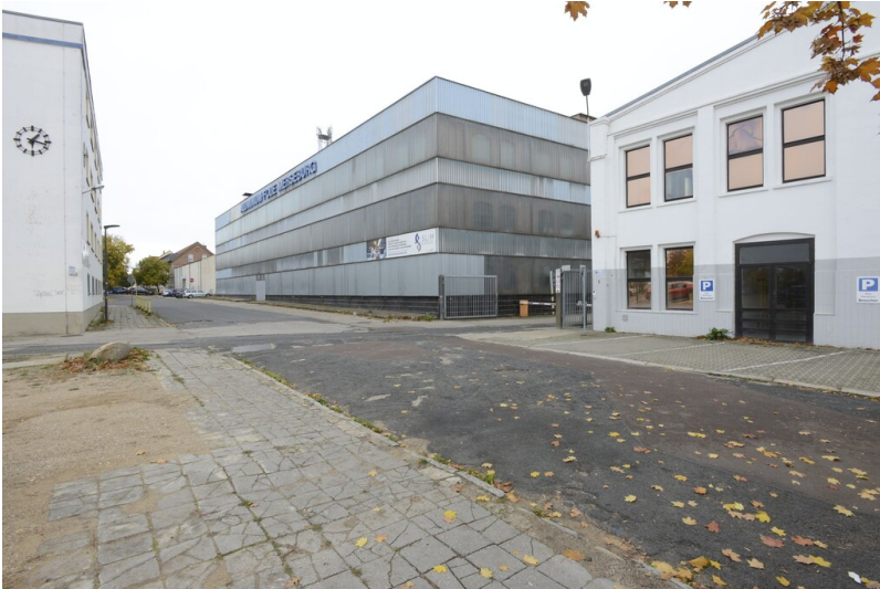
Standort ehemalige Blancke-Werke - Unter der überformten Fassade des Produktionsgebäudes erscheint der ziegelsichtige Originalbestand (Mitte) Fotograf/Urheber: NAME FEHLT
