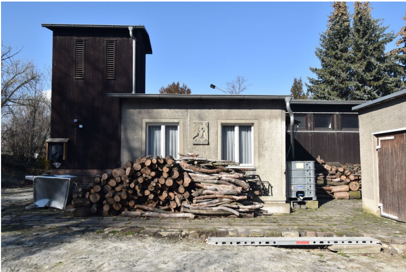
Katholische Kirche St. Anna Schkopau - Ostfassade Fotograf/Urheber: NAME FEHLT
