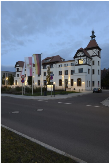
Kurhaus Bad Dürrenberg - Kurhaus Bad Dürrenberg Fotograf/Urheber: NAME FEHLT
