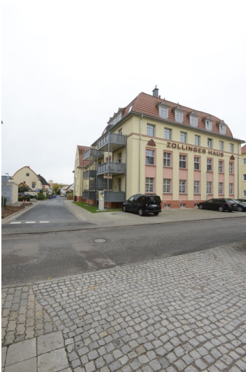
Wohlfahrts- und Arbeitsamt - Zollinger-Haus Fotograf/Urheber: NAME FEHLT
