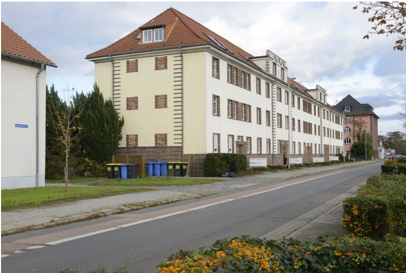
Wohnhauszeile Leuna Fotograf/Urheber: NAME FEHLT
