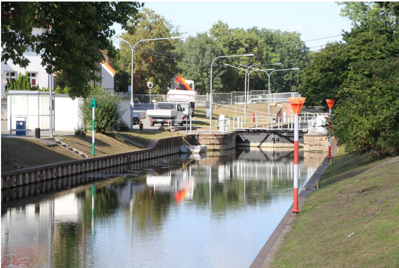
Schleuse Meuschau Fotograf/Urheber: NAME FEHLT
