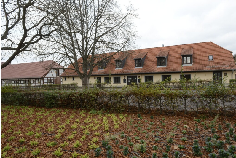
Wirtschaftsgebäude der Saline Fotograf/Urheber: NAME FEHLT
