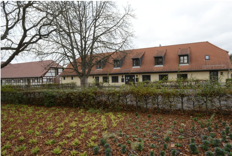
Wirtschaftsgebäude der Saline Fotograf/Urheber: NAME FEHLT
