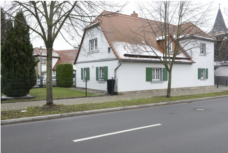
Wohngebäude eines Salzsieders Fotograf/Urheber: NAME FEHLT
