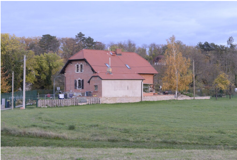
Schleuse Bad Dürrenberg - Das Schleusenwärterhaus Fotograf/Urheber: NAME FEHLT
