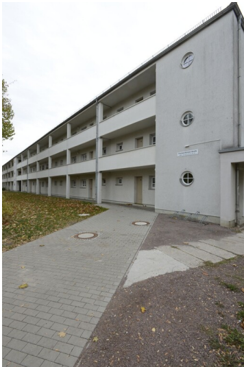
Alte Siedlung Bad Dürrenberg - Gebäudeerschließung mithilfe eines Laubenganges Fotograf/Urheber: NAME FEHLT
