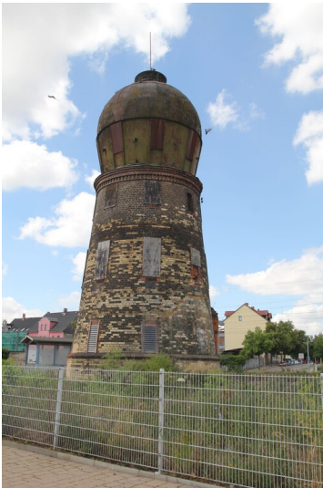
Eisenbahnwasserturm in Merseburg Fotograf/Urheber: NAME FEHLT
