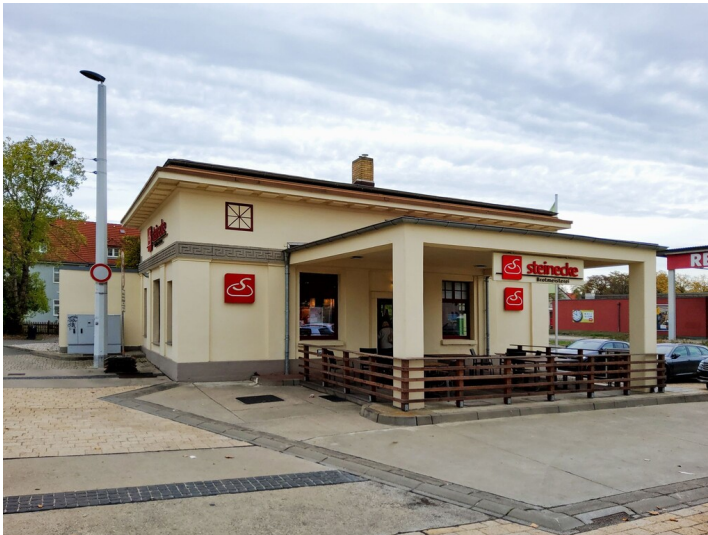
Ehemalige Tankstelle der Leuna-Werke - Hauptfassade in Richtung Platz (Südfassade) Fotograf/Urheber: NAME FEHLT
