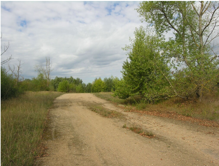
Provisorischer Damm für eine Baggerumsetzung - provisorischer Damm; Blick NW Fotograf/Urheber: NAME FEHLT
