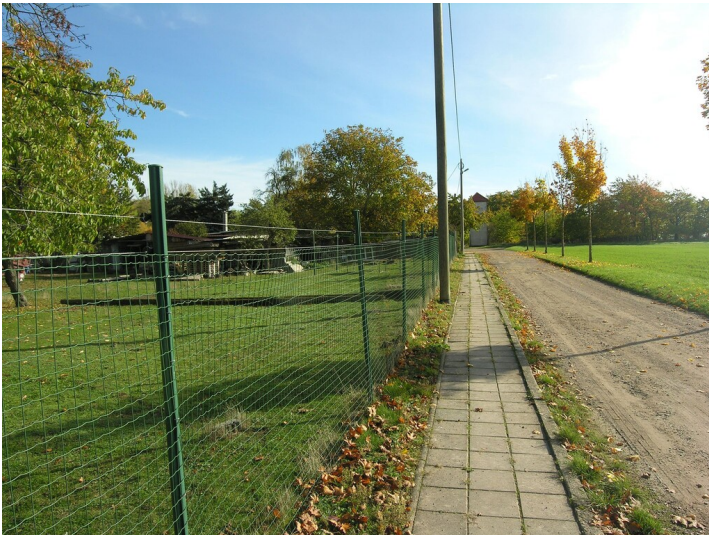
Schamottewaren-Fabrik Mariewerk - Fabrikgelände der ehemaligen Ziegelei Marie; Straße "Am Schacht", Blick Süd Fotograf/Urheber: NAME FEHLT
