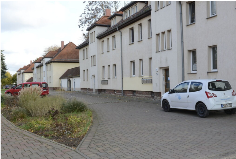
Bergmannssiedlung Frankleben - Blick entlang des Weges ""Bergmannssiedlung"" Fotograf/Urheber: NAME FEHLT
