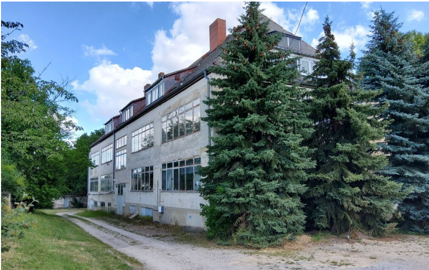
Siedlung Wintershall Krumpa - Schulgebäude Fotograf/Urheber: NAME FEHLT
