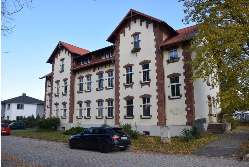
Verwaltungsgebäude der Brikettfabriken Michel und Vesta - Seestraße 33-34 Fotograf/Urheber: NAME FEHLT
