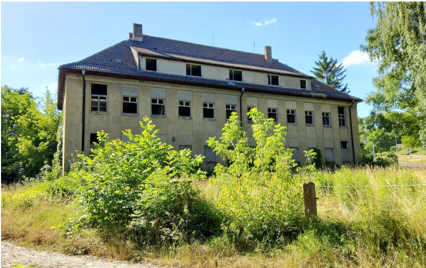
Wohngebäude der Kursächsischen Braunkohlen-Gas-und Kraft-Gesellschaft m.b.H. - Übernachtungsgebäude Fotograf/Urheber: NAME FEHLT
