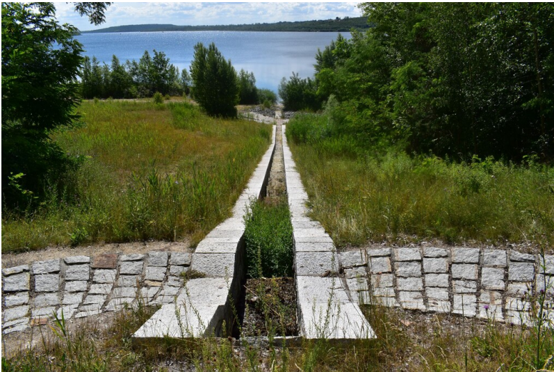
Einlaufbauwerk Stöbnitz - Durch das Einlaufbauwerk Stöbnitz fließt das kleine Flüsschen Stöbnitz in den Geiseltalsee Fotograf/Urheber: NAME FEHLT
