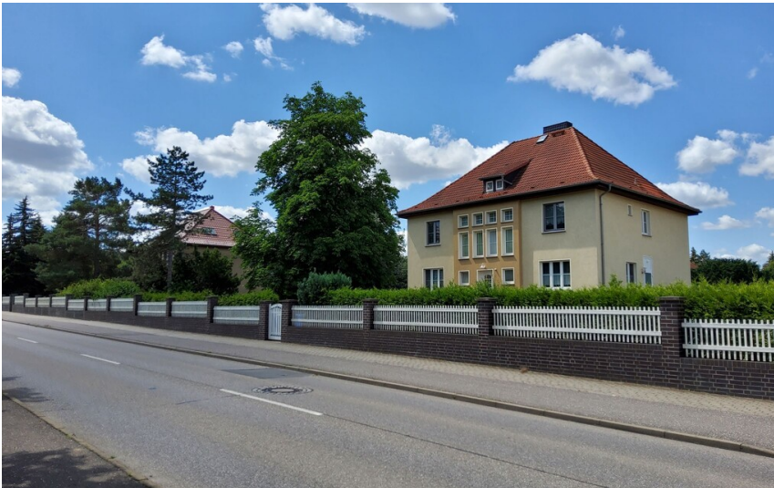
Werkssiedlung Krumpa - Schortauer Weg 18 Fotograf/Urheber: NAME FEHLT
