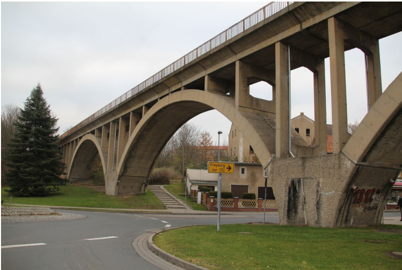
Eisenbahnviadukt Mücheln - Blick nach Süden Fotograf/Urheber: NAME FEHLT
