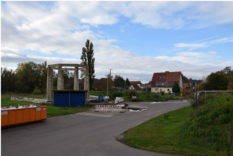
Gesamtstandort Brikettfabrik Pfännerhall - Blick auf Wasserturmrelikt und Siedlung Fotograf/Urheber: NAME FEHLT
