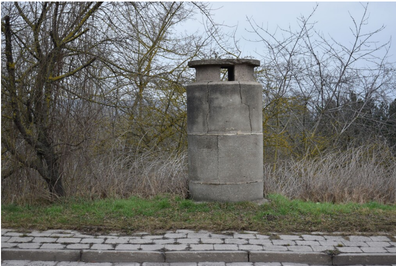
Einmannbunker - Splitterschutzzelle für Sprengarbeiten im Tagebau Fotograf/Urheber: NAME FEHLT
