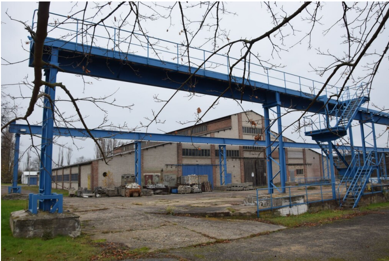
Werkshallen Kesselbau Stöbnitz Fotograf/Urheber: NAME FEHLT
