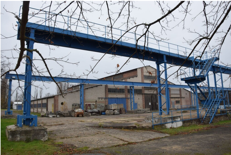
Werkshallen Kesselbau Stöbnitz Fotograf/Urheber: NAME FEHLT
