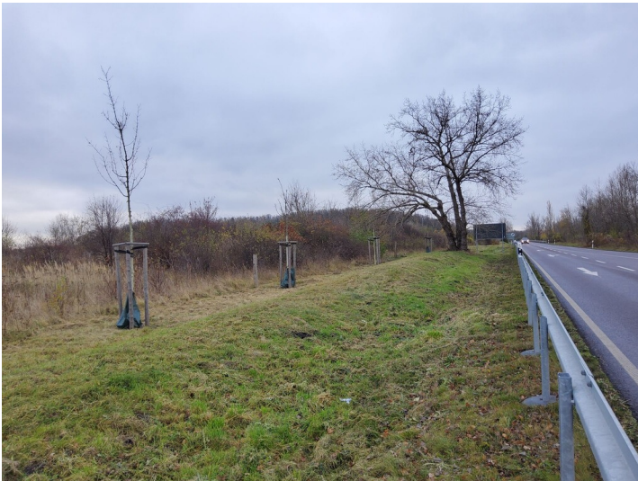
Bahnstrecke Beuna-Großkayna - Dammartige Erhebung neben der modernen Straße. Möglicherweise handelt es sich um einen Rest der Kohlebahn. Blick nach S. Fotograf/Urheber: NAME FEHLT
