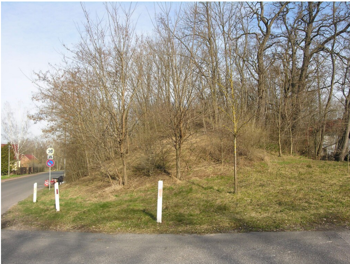
Bahndamm zur Brikettfabrik Gute Hoffnung - Damm an der Südstraße Fotograf/Urheber: NAME FEHLT
