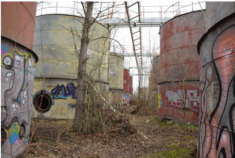
Mineralölwerk Lützkendorf ("Addinolwerk") - Tanklager Fotograf/Urheber: NAME FEHLT
