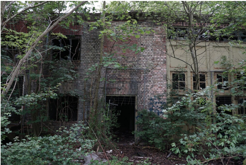
Elektrizitätszentrale des Mineralölwerkes Lützkendorf - Zustand am 24.05.2020 Fotograf/Urheber: NAME FEHLT
