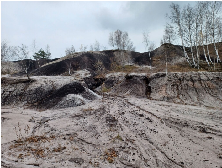
Abbaufeld "Südfeld" des Tagebau Kayna-Süd - Das ehemalige Baufeld "Südfeld" ist heute mit umfangreichen Abraumphalden der Braunkohlenindustrie verfüllt. Noch immer sind die verschiedenen Schüttkippen zu erkennen. Blick nach O. Fotograf/Urheber: NAME FEHLT
