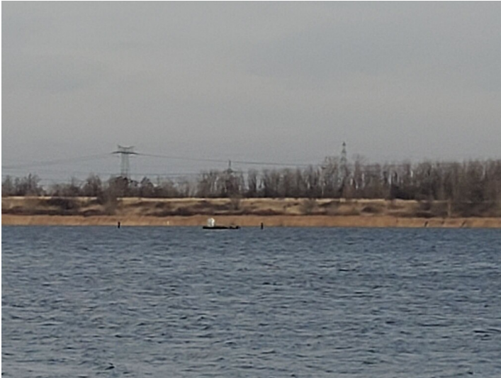
Runstedter See - Tiefenwasserbelüftungsanlagen Fotograf/Urheber: NAME FEHLT
