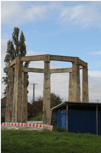
Relikt eines Wasserturms - Betonskelett eines Wasser- oder Kühlturms Fotograf/Urheber: NAME FEHLT
