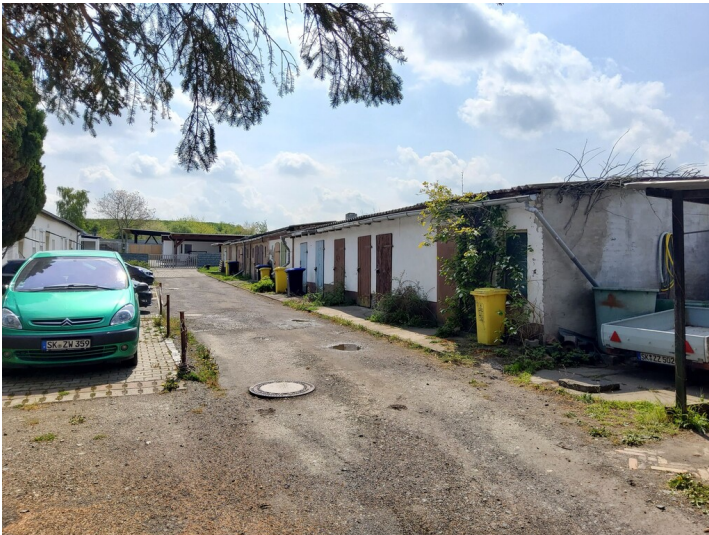
Nebengebäude der Grube Louise - Nebengebäude Steigerhaus, ehemaliger Stall und Waschhaus Fotograf/Urheber: NAME FEHLT
