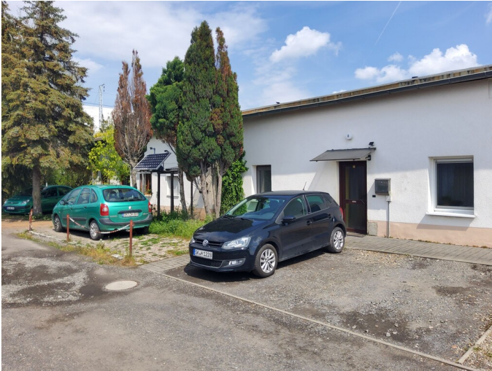
Steigerwohnhaus Grube Louise - Nördlicher Teil Fotograf/Urheber: NAME FEHLT
