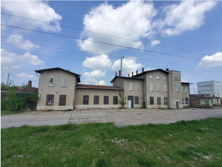
Bahnhof Teutschenthal - Fassade zur Reichsbahnstraße Fotograf/Urheber: NAME FEHLT
