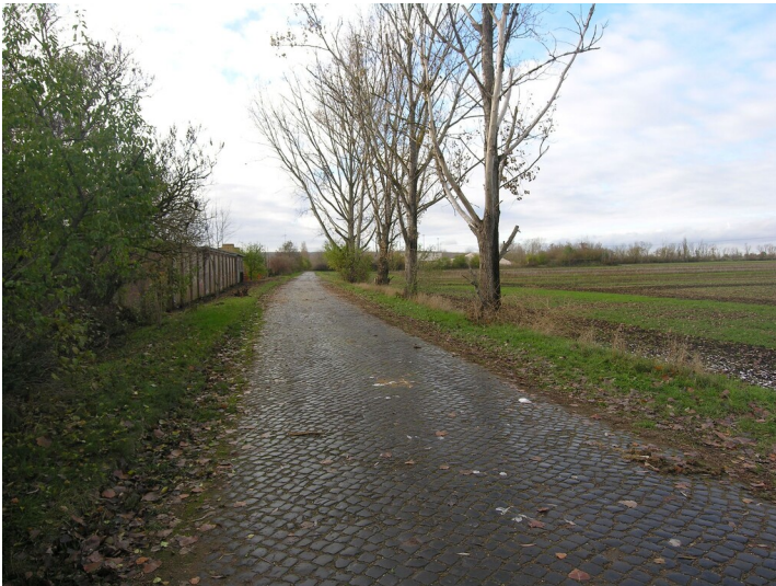
Alte Kreisstraße - Alte Kreisstraße beim Etdorfer Gut; Blick W Fotograf/Urheber: NAME FEHLT
