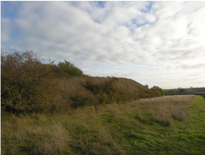
Hochdamm - Hochdamm der Abraumbahn; Blick S Fotograf/Urheber: NAME FEHLT
