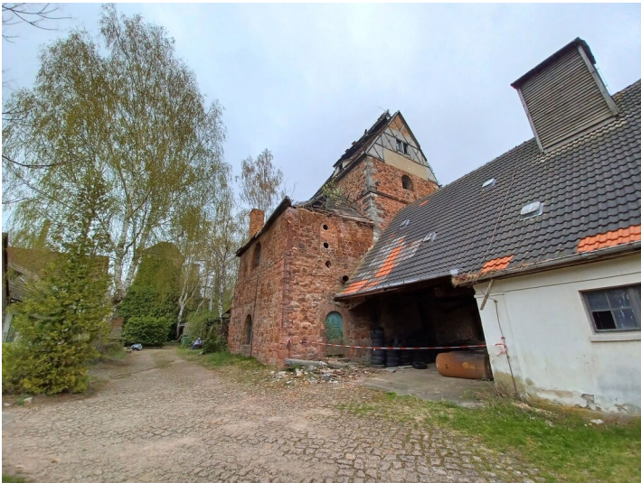
Ziegelei und Kaolinwerk Salzmünde - Ziegeleigebäude Rückseite Fotograf/Urheber: NAME FEHLT
