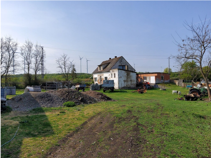
Gebäude der Schwelerei Klotz - Blick nach Südwesten Fotograf/Urheber: NAME FEHLT
