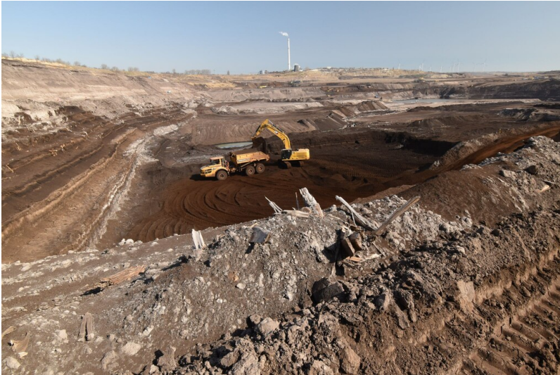
Großtagebau Amsdorf - Mobiles Abbaugerät im Tagebau; Blick zum Werksgelände Fotograf/Urheber: NAME FEHLT
