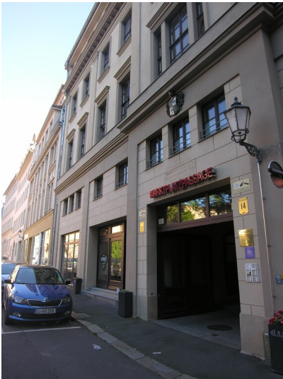
Verwaltungsgebäude der Sächsisch-Thüringischen Aktiengesellschaft für Braunkohlen-Verwertung - Straßenansicht des ehemaligen Verwaltungsgebäudes Fotograf/Urheber: NAME FEHLT
