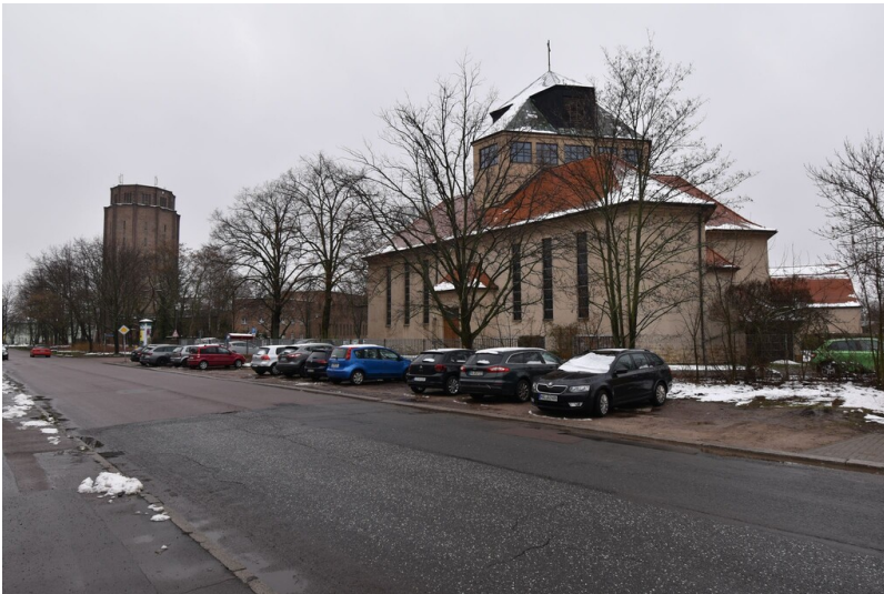
Kirche Zur Heiligsten Dreifaltigkeit - Straßenansicht der Kirche Fotograf/Urheber: NAME FEHLT
