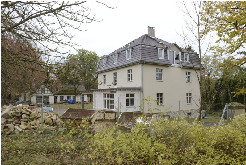
Verwalterwohnhaus des Wentzelschen Gutes Fotograf/Urheber: NAME FEHLT
